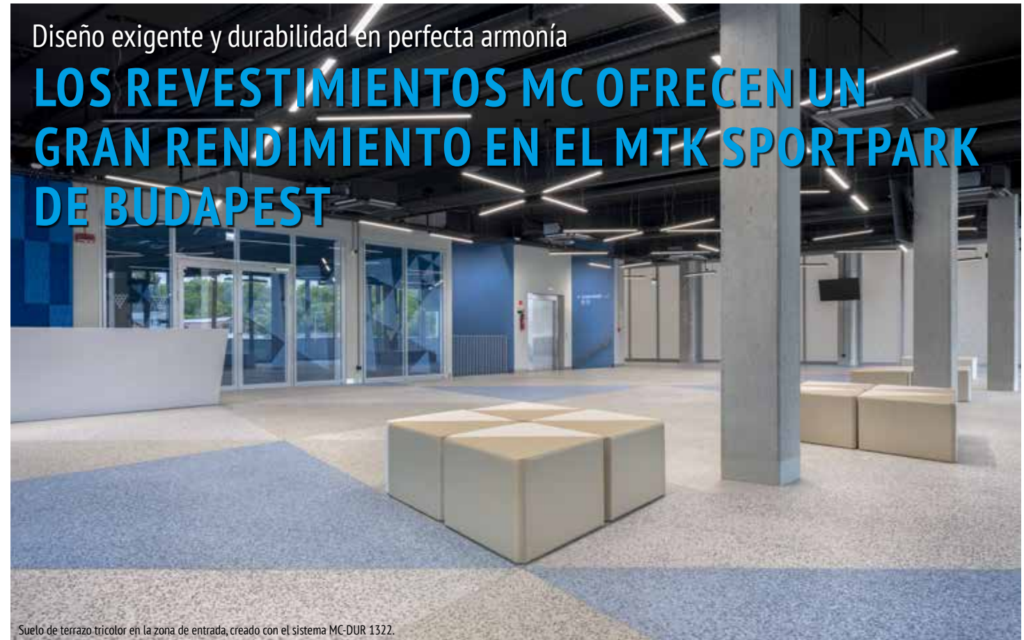
Suelo de terrazo tricolor en la zona de entrada, creado con el sistema MC-DUR 1322.
