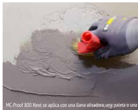
MC-Proof 800 Next se aplica con una llana alisadora, una paleta o una
