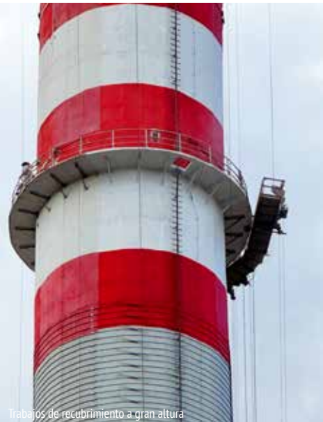
Trabajos de recubrimiento a gran altura
