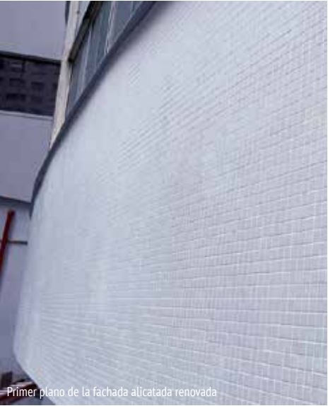
Primer plano de la fachada alicatada renovada
